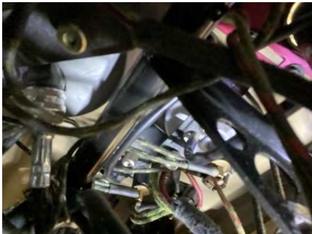
Aufgeräumt unter dem Armaturenbrett
